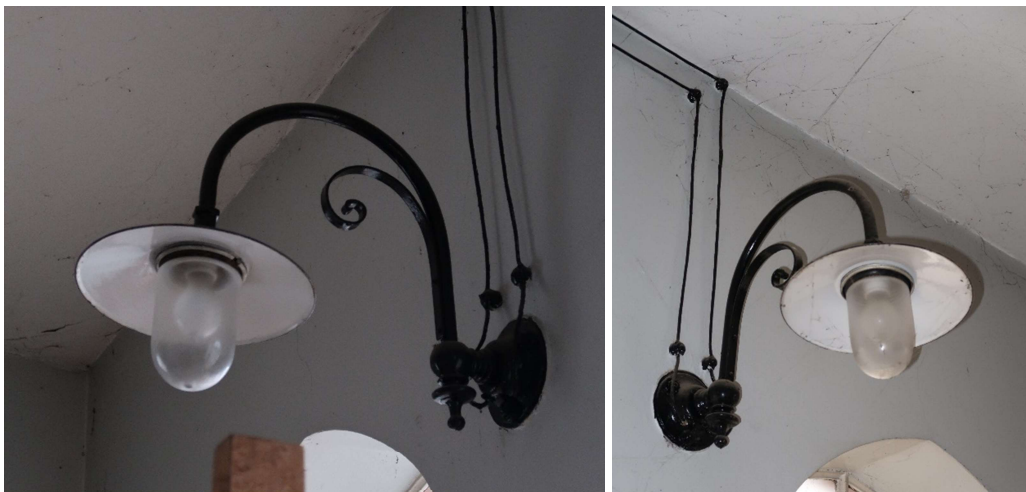
Bevarade armaturer på den norra väggen med äldre utanpåliggande ledningar.
