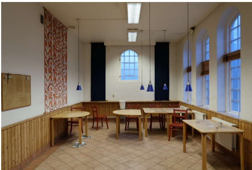
Den södra lågdelen karakteriseras interiört av sentida ombyggnader med ny planlösning och ytskikt.
