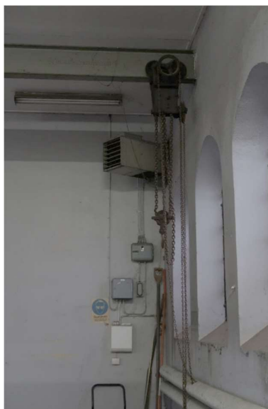
Bevarad travers som löper i öst-västlig riktning.
