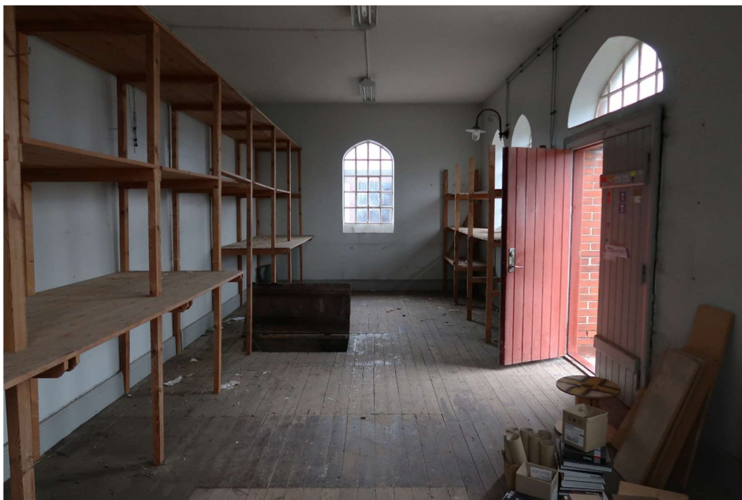
Vy över verkstaden mot väster. Notera trägolvet med alla dess lagningar efter tidigare fundament.
