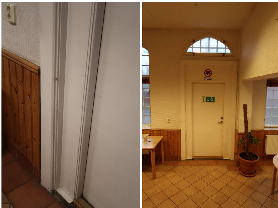
Bevarad karm till ytterdörr mot söder. Ovan dörrbladet har suttit ett rektangulärt spröjsat fönster, vilket framkommer av äldre ritningar.
