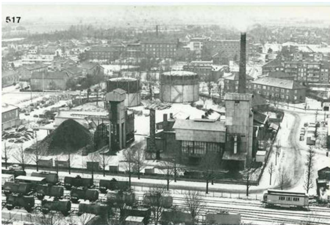
Bilden föreställer gasverksområdet med "nya gasverket" i förgrunden. Okänt datum men sannolikt är bilden tagen mellan 1957 och 1972.
