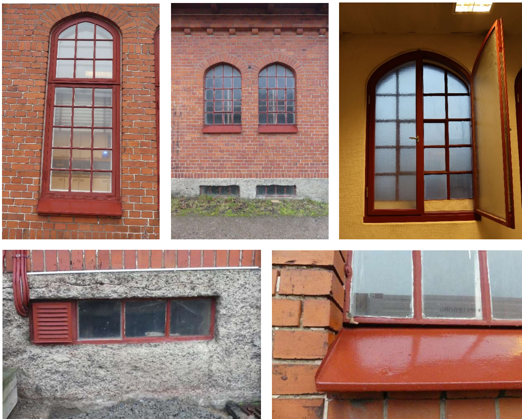
Byggnaden har tre fönstertyper: höga småspröjsade träfönster på södra gaveln, höga småspröjsade enkla gjutjärnsbågar samt mindre källarfönster av gjutjärn.
