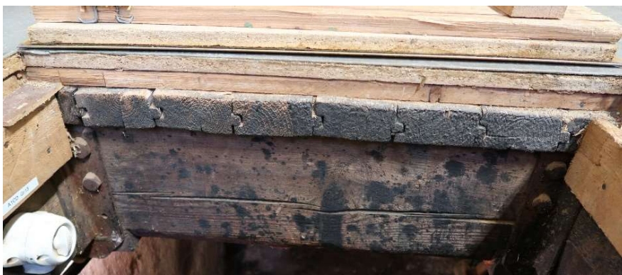
Vid nedgången till källaren framträder det ursprungliga brädgolvet under nuvarande golv.
