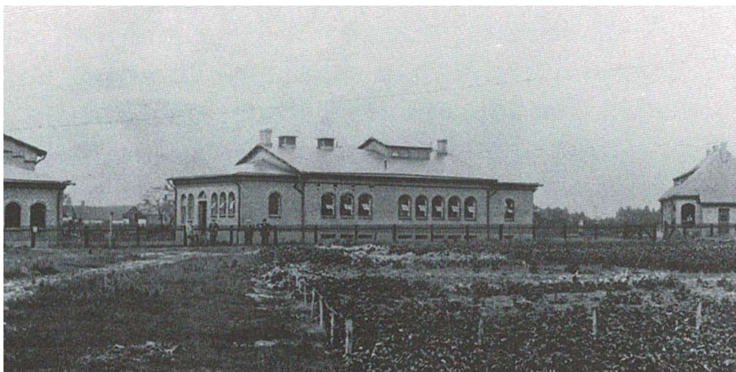
Byggnadens östra fasad mot det som senare blev Skyttsgatan.
